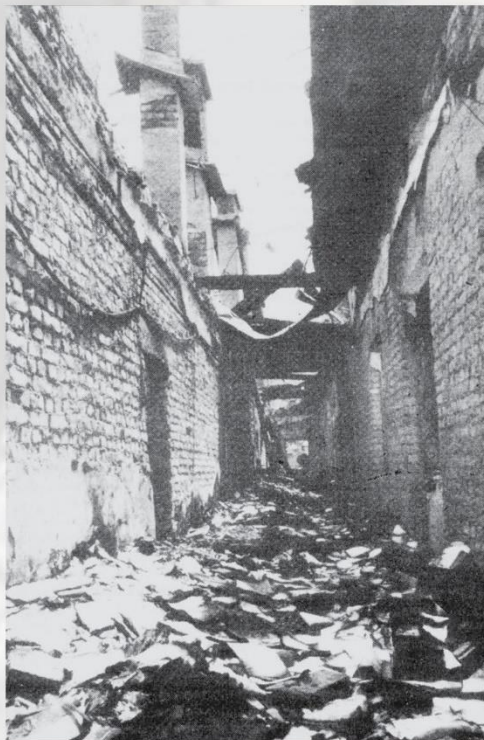
Unutrašnjost Orijentalnog instituta nakon požara
